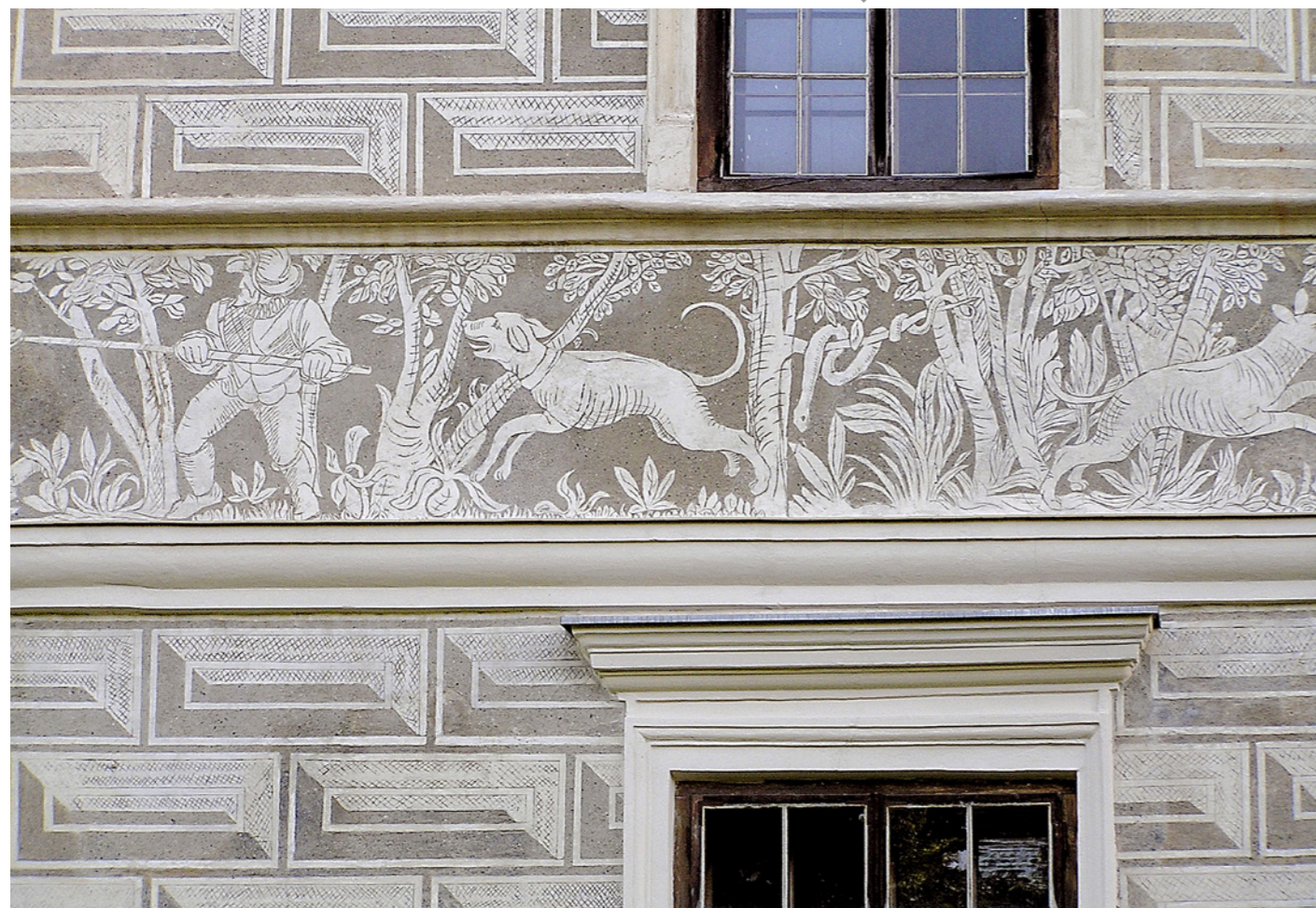
Sgraffito - przykład zastosowania barwionego tynku wierzchniego jako końcowej dekoracji bez farby elewacyjnej.
