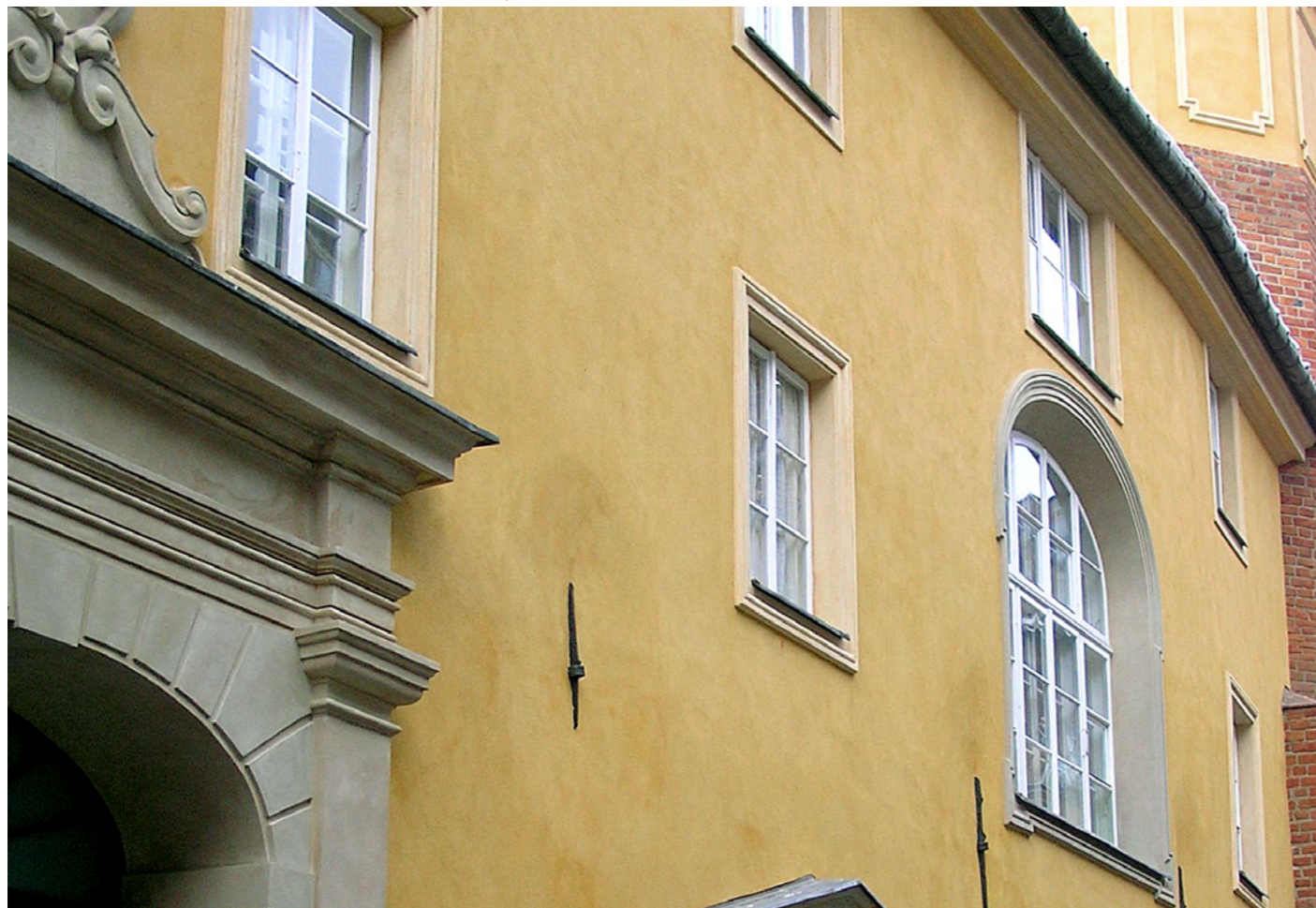
Wybarwione w masie wyprawy tynkarskie na zabytkowej elewacji.
